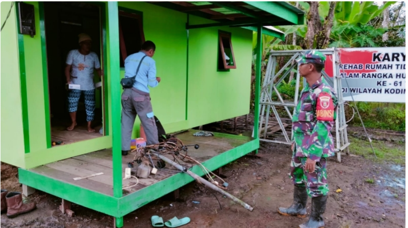
Melengkapi Renovasi RTLH Babinsa 1005-03/Rantau Badauh Monitoring Instalasi Listrik Dipasang
